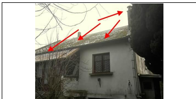
Photo n° DSCNA001 Localisation : Toiture Ouvrage : 1 - Couvertures, Toitures, Terrasses et étanchéités - Ardoises, bardeaux bitumineux Partie d'ouvrage : Ardoises en fibro ciment Description : Ardoises en fibro ciment
