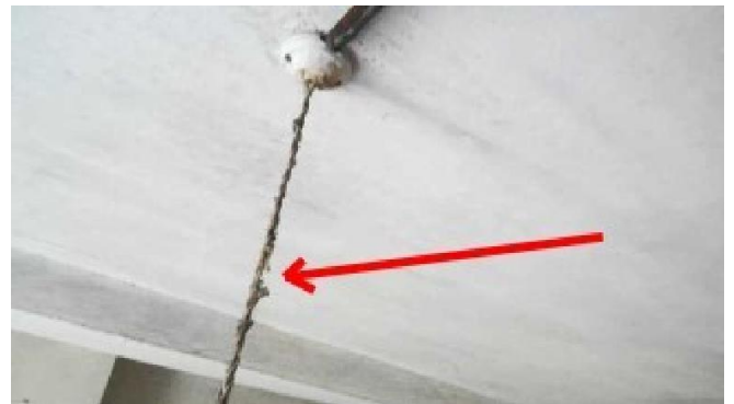
B.8.3 d) : L'installation comporte au moins un conducteur actif dont le diamètre est inférieur à 12/10 mm (1,13 mm 2 ). Observation : Fil tissu torcadé.
