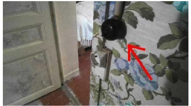
B.8.3 a) : L'installation comporte au moins un matériel électrique vétuste. Observation : Interrupteur (bakéllité) vétuste.
