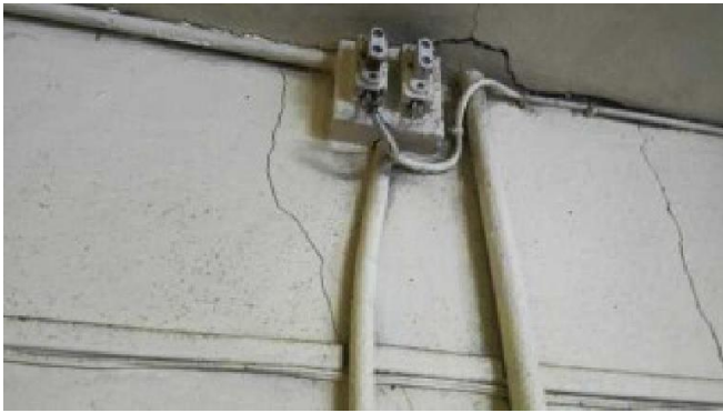
B.7.3 e) : L'installation électrique comporte au moins un dispositif de protection avec une partie active nue sous tension accessible. Observation : Accès direct au fusibles.
