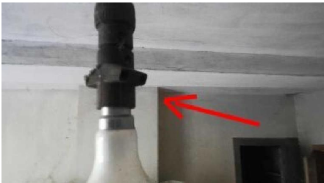
B.8.3 b) : L'installation comporte au moins un matériel électrique inadapté à l'usage. Observation : Multiprise sur douille.
