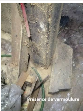
Pathologie : Traces d'infestations d'insectes à larves xylophages
