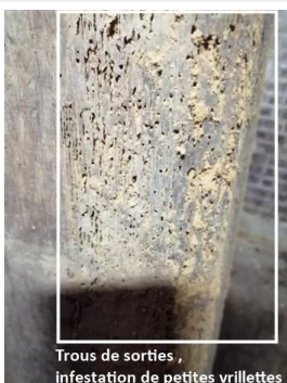
Pathologie : Traces d'infestations d'insectes à larves xylophages
