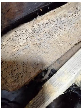
Pathologie : Traces d'infestations d'insectes à larves xylophages
