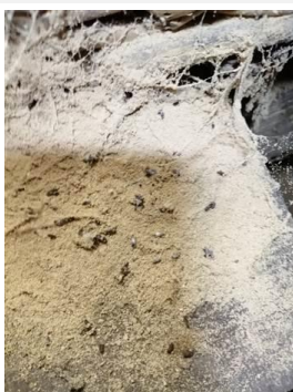
Pathologie : Traces d'infestations d'insectes à larves xylophages
