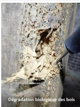
Pathologie : Traces d'infestations d'insectes à larves xylophages
