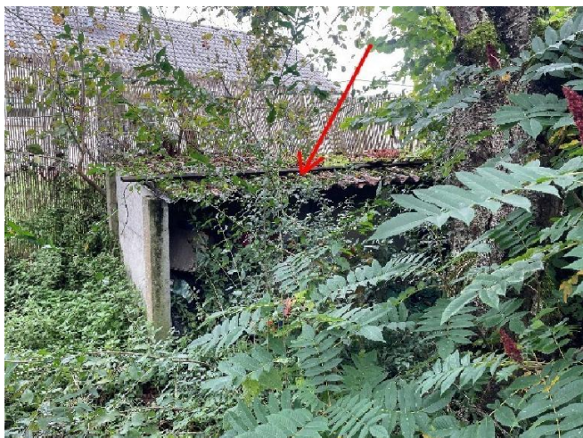
Extérieurs : Abris bois Toiture en plaques ondulées fibre-ciment.
