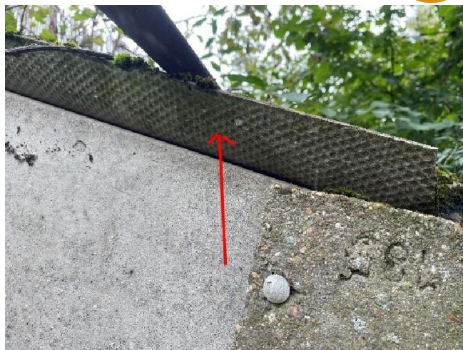
Extérieurs : Abris bois Détail plaques ondulées fibre-ciment.
