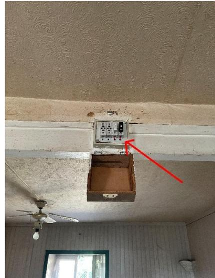
**B.4.3 b)** : Le type d'au moins un fusible ou un disjoncteur n'est plus autorisé (fusible à tabatière, à broches rechargeables, coupe-circuit à fusible de type industriel, disjoncteur réglable en courant protégeant des circuits terminaux).
