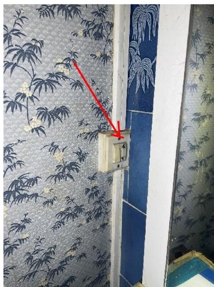
**B.5.3 a)** : Locaux contenant une baignoire ou une douche : la continuité électrique de la liaison équipotentielle supplémentaire, reliant les éléments conducteurs et les masses des matériels électriques, n'est pas satisfaisante (résistance supérieures à 2 ohms).
