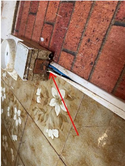
**B.8.3 e)** : Au moins un conducteur isolé n'est pas placé sur toute sa longueur dans un conduit, une goulotte, une plinthe ou une huisserie, en matière isolante ou métallique, jusqu'à sa pénétration dans le matériel électrique qu'il alimente.
