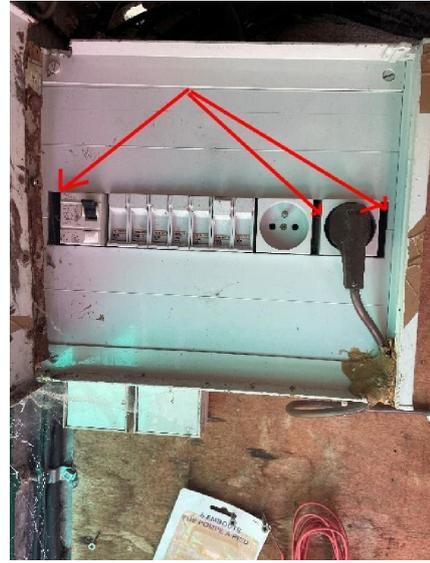
**B.7.3 e)** : L'installation électrique comporte au moins un dispositif de protection avec une partie active nue sous tension accessible.
