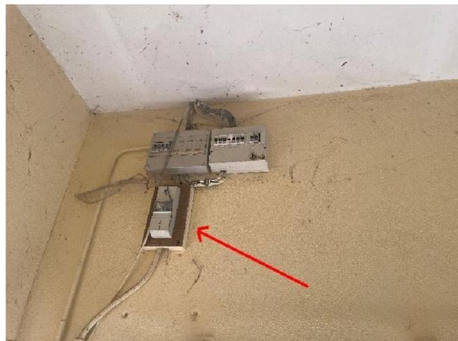
**B.1.3 g)** : Le dispositif assurant la coupure d'urgence est placé à plus de 1,80 m du sol fini et n'est pas accessible au moyen de marches ou d'une estrade.
