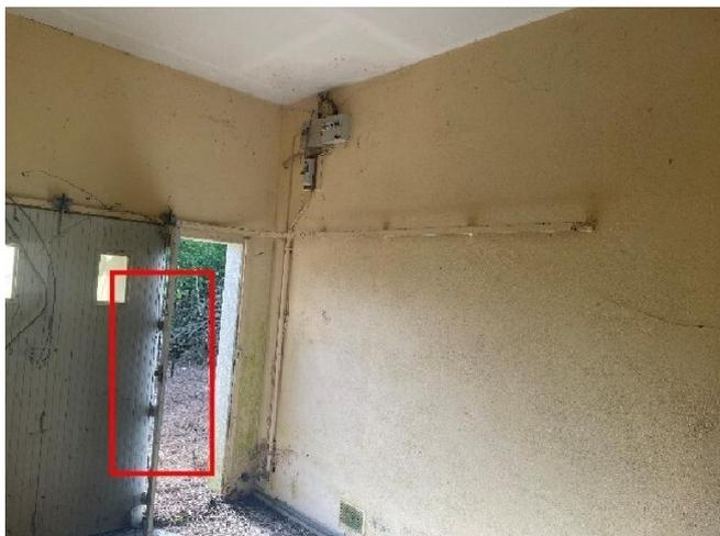
**B.1.3 b)** : Le dispositif assurant la coupure d'urgence n'est pas situé à l'intérieur du logement ou dans un emplacement accessible directement depuis le logement.
