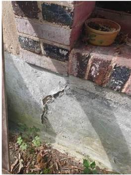
Présence d'une fissure verticale fine sur le mur extérieur sous une fenêtre:
