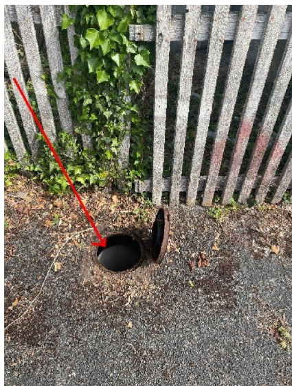
Regard eaux usées sur la voie publique.
