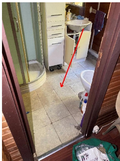
Prélèvement P002 Salle de douche-toilettes Dalles de sol
