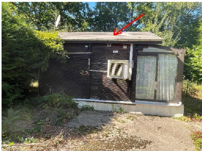
Prélèvement P001 Exterieur Toiture chalet Bardeaux bitumineux
