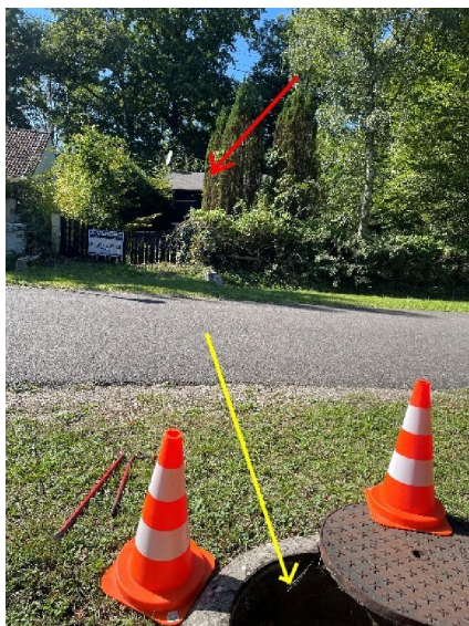
Flèche rouge ... Chalet Flèche Jaune ... Tampon eaux usées sur voie publique.
