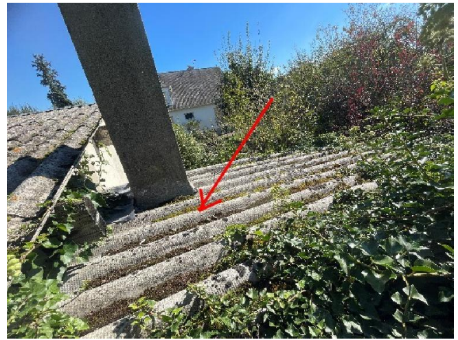
Exterieurs : Toiture chaufferie Plaques ondulées fibre-ciment.
