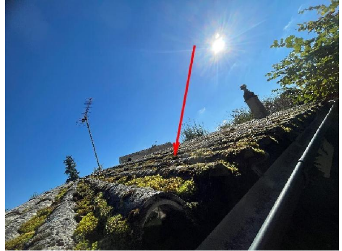
Exterieurs : Toiture combes 03 Plaques ondulées Fibre-Ciment.
