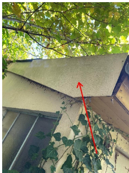
Exterieurs : Rives de toiture Plaques Fibre-Ciment
