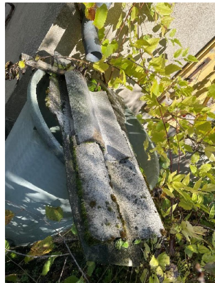
Extérieurs : Arrière atelier 02 Plaques ondulées en Fibre-Ciment.
