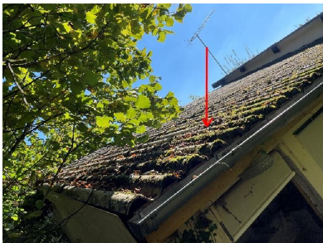
Exterieur : Toiture Comble 01 et 02 Plaque ondulées Fibre-Ciment.
