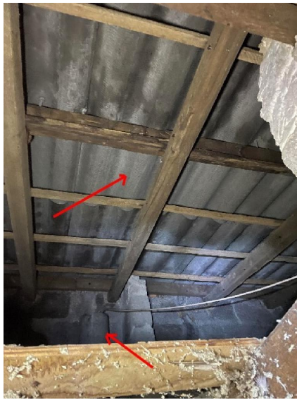
Combles 02 Vue par la trappes située dans le séjour - Toiture plaques ondulées Fibre-Ciment - Conduit fumées Fibre-Ciment.
