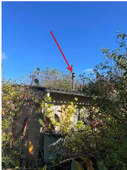
Exterieurs : Toiture atelier 01 et 02. Conduit fumées en Fibre-Ciment.
