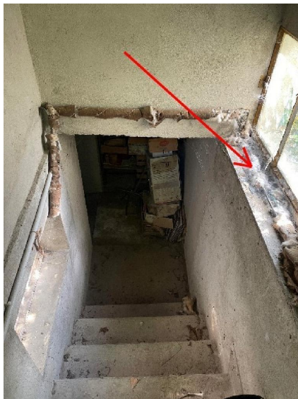
Prélèvement P001 Descente vers la cave : Calorifugeage NON AMIANTE
