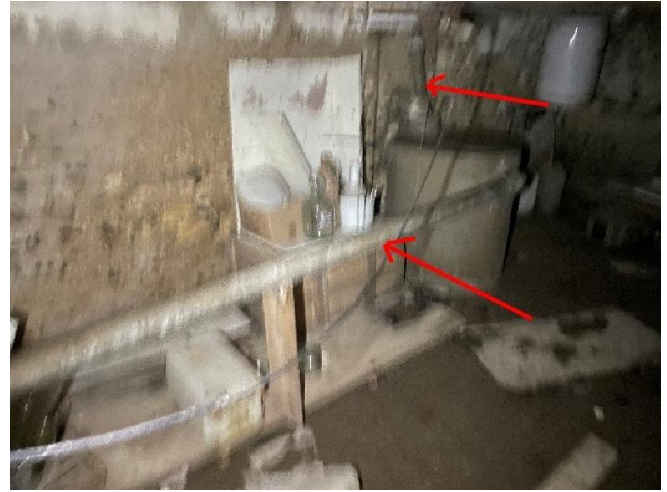
Maison 02 Cave Local 01 Conduits fibres ciment.
