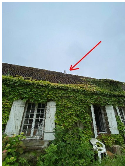
Exterieurs : Toiture maison 02 Conduit fibre ciment
