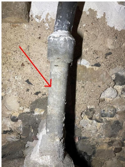
Maison 02 Cave local 01 Conduit fibre ciment mur Nord/Ouest.
