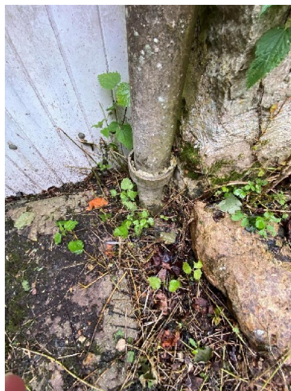
Exterieurs : Détail conduit fibre-ciment.
