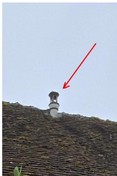
Exterieurs Toiture maison 02 Détail conduit fibre-ciment.
