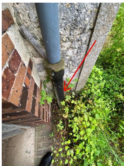
Exterieurs : Mur Sud/Ouest grange ... angle grange/maison 02 Conduit fibre-ciment
