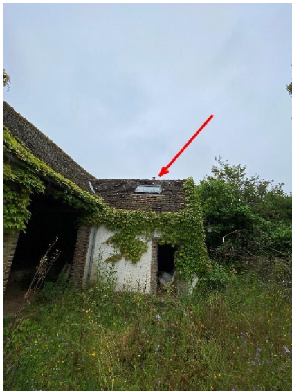
Exterieurs : Toiture maison 03 Conduit fibre-ciment.
