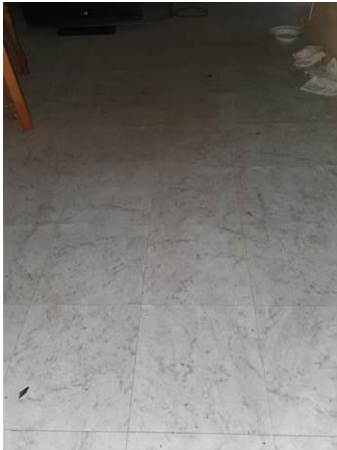
Photo n° Ph015 Localisation : Sous-Sol - Pièce 1 Ouvrage : Planchers Partie d'ouvrage : Dalles de sol Description : Dalles de sol
