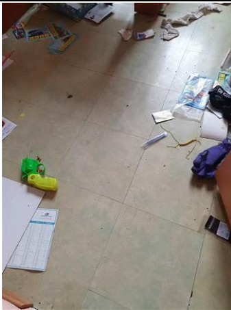
Photo n° Ph016 Localisation : RdC - Bureau Ouvrage : Planchers Partie d'ouvrage : Dalles de sol Description : Dalles de sol
