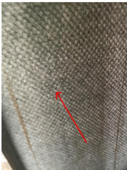
Local 01 Détail panneau fibre-ciment.
