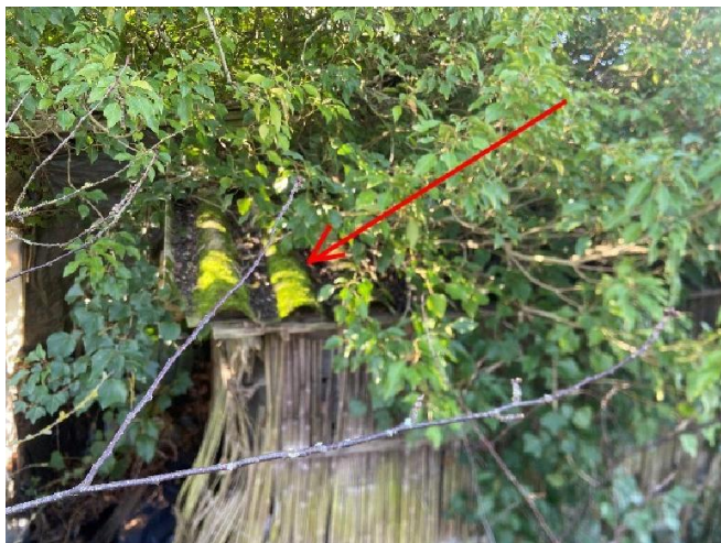
Toiture Local 03 prologation Plaques ondulées fibre-ciment.
