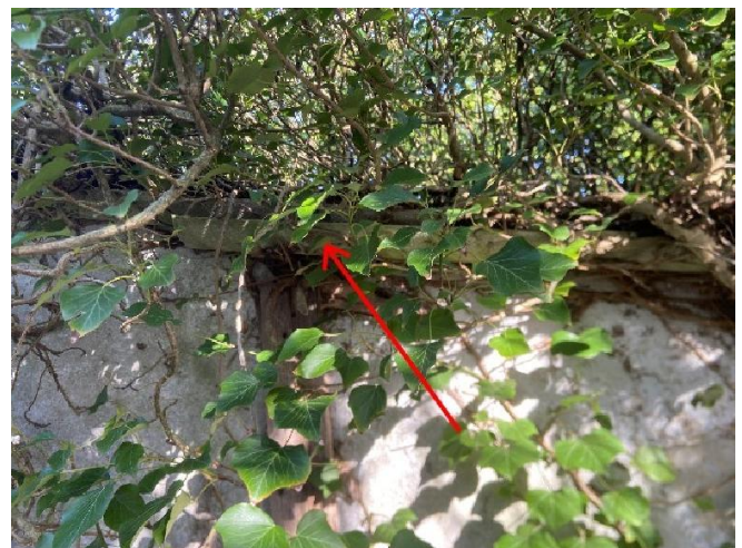
Local 03 toiture Plaques ondulée fibre-ciment.
