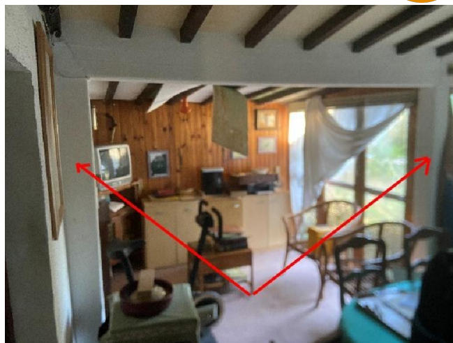
Séjour extension -Conduit fibre ciment
