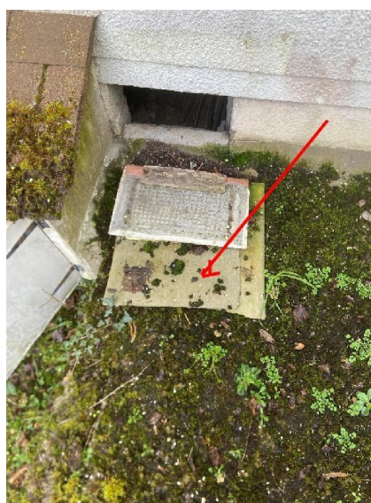
Maison mur Nord Plaque fibre ciment.
