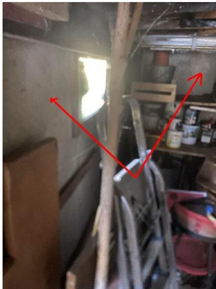
Local 01 Murs Sud/Ouest et Nord Plaque fibre ciments
