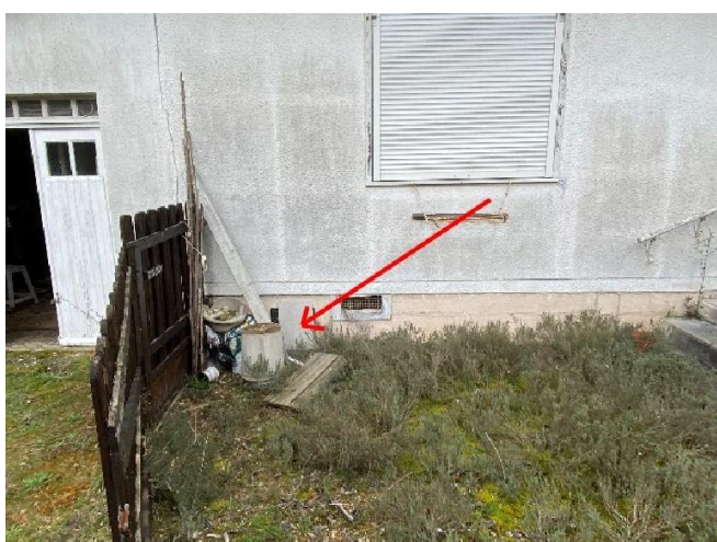
Maison mur Sud. Plaque fibre ciment.
