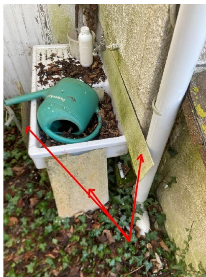
Evier Extérieur. 3 plaques fibre-ciment.
