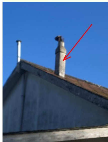
Toiture versant Sud. Conduit fumées en fibre-ciment.
