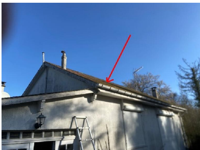
Toiture Maison. Ardoise amiante.
