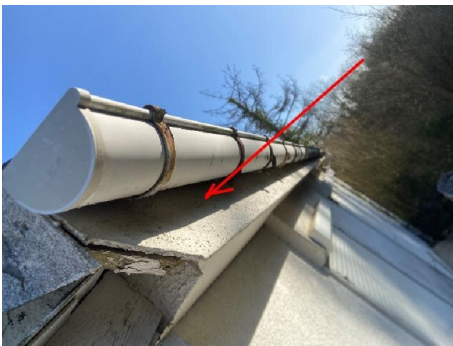
Toiture Maison. Support gouttière. -Plaques fibre-ciment.
