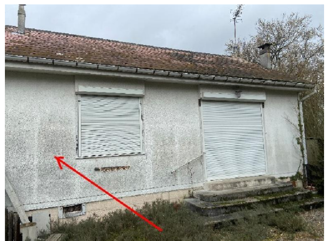
Maison extérieur (ossature bois) Murs Nord/Est/Ouest et Sud de la maison d'origine en plaques fibre-ciment.
