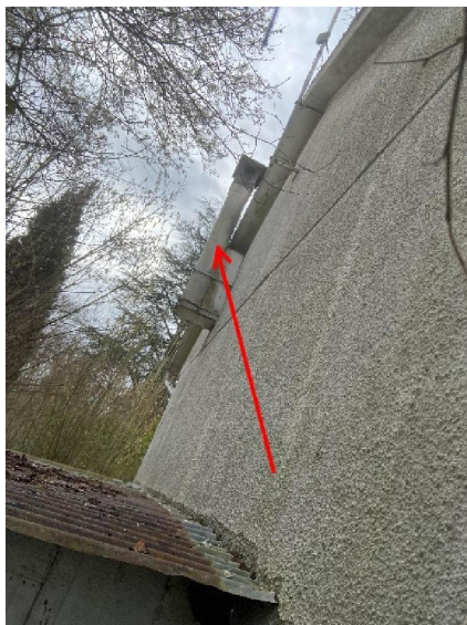
Pignon Est de la maison. Conduit fumée en fibre-ciment.
