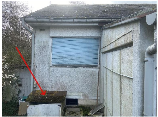
Prélèvement P002 Local 04 Bardeaux bitumineux.
