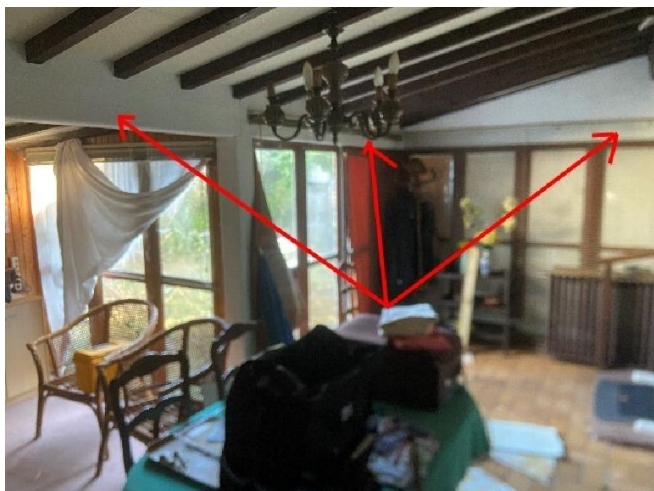
Séjour (extension) Conduits fibre-ciment.
