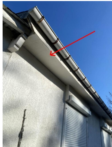
Maison toiture, cahe moineaux Sud et Nord Plaques fibre ciment.
