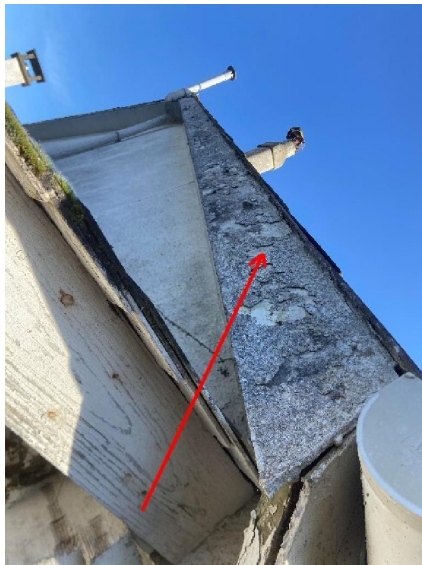
Maison Toiture. Rives Est et Ouest.
