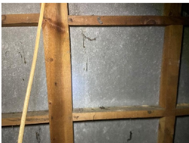
Combles maison. Pignons Ouest et Est plaque fibre-ciment.
