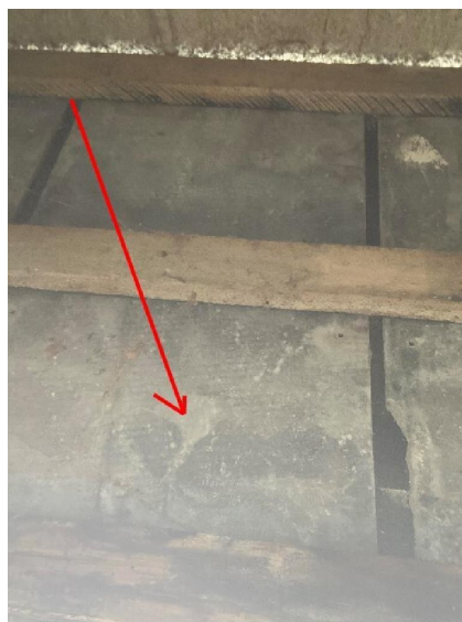
Local 04, sous toiture. Plaque fibre-ciment.
